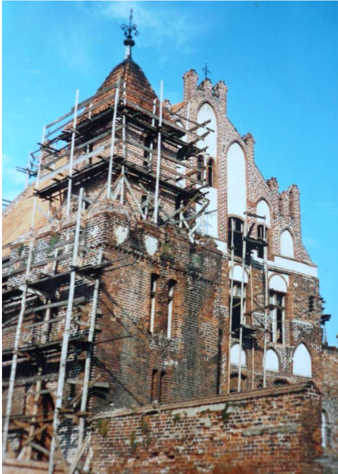
Poortgebouw in de steigers
